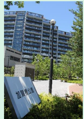
マンション開発に伴う提供公園と防災倉庫
