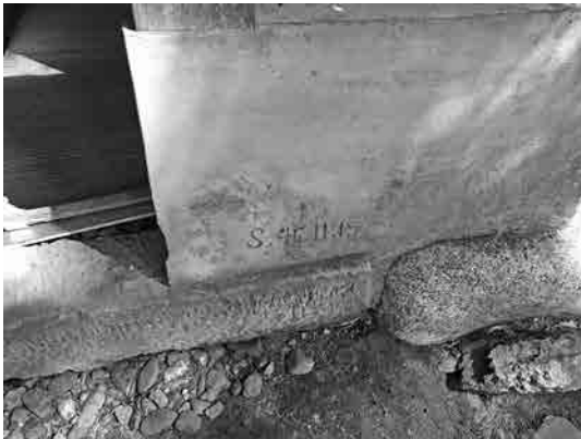
写真11 社殿壁面。昭和46年11月15日に落成したと思われる
