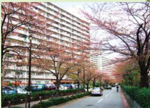
Takashimadaira apartment complex / 高島平団地
