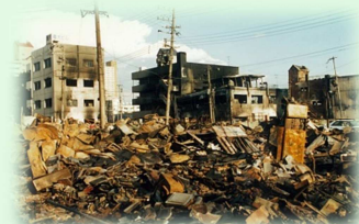
阪神・淡路大震災の延焼火災
