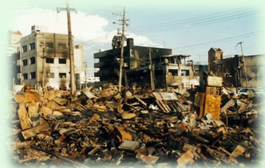
阪神・淡路大震災の延焼火災
