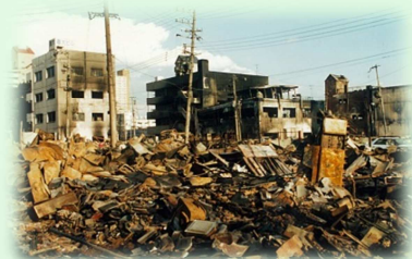
阪神・淡路大震災の延焼火災
