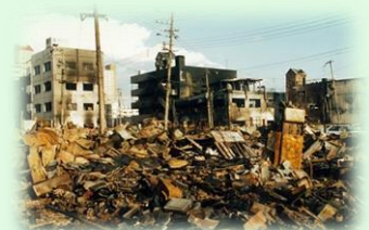
阪神・淡路大震災の延焼火災
