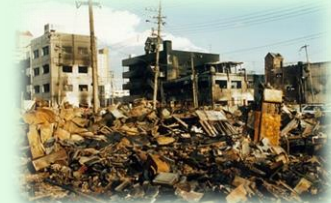
阪神・淡路大震災の延焼火災
