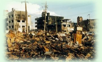
阪神・淡路大震災の延焼火災
