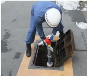
吐水口にスタンドパイプを、放水弁にスピンドルドライバーを結合する。
