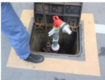
スピンドルドライバーを反時計回りに回して、スタンドパイプから水が出るか確認する。水が出るのを確認したら、すぐに時計回りに回して消火栓を閉鎖する。水圧が強いのでゆっくりと回して解放する。
