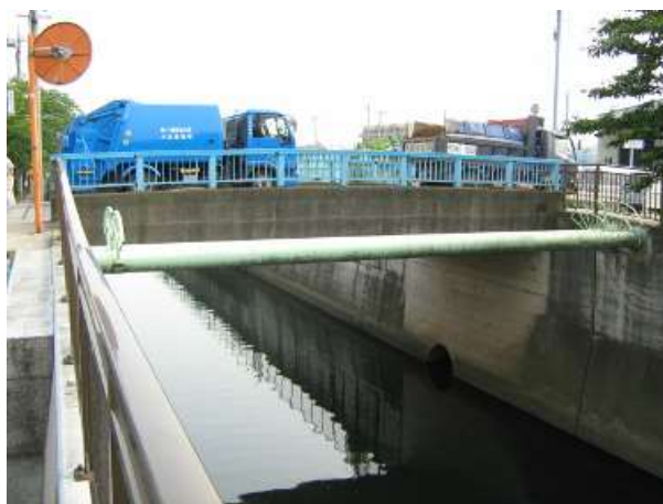
水道橋（和光市）
