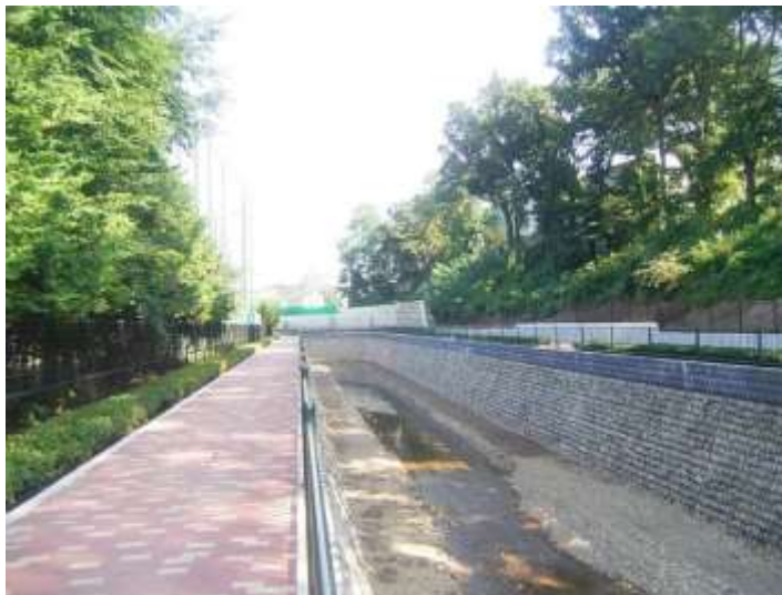
【石神井川の河川改修工事：平成22年度完成 溜漕橋上流 西東京市東伏見三丁目地内】
