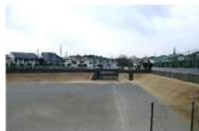
西東京市 向台調節池
