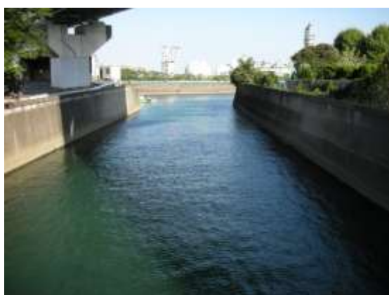
石神井川河口付近
