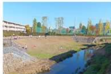
西東京市 弥生橋付近 (親水整備箇所)
