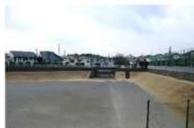
西東京市 向台調節池
