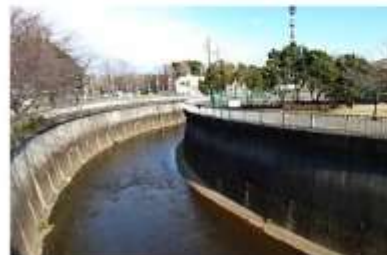
板橋区 栗原橋付近
