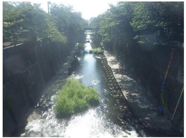
石神井川 ①久保田橋付近 久保田橋上より下流方向
