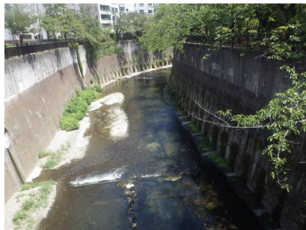
石神井川 ②緑橋付近 緑橋下より下流方向
