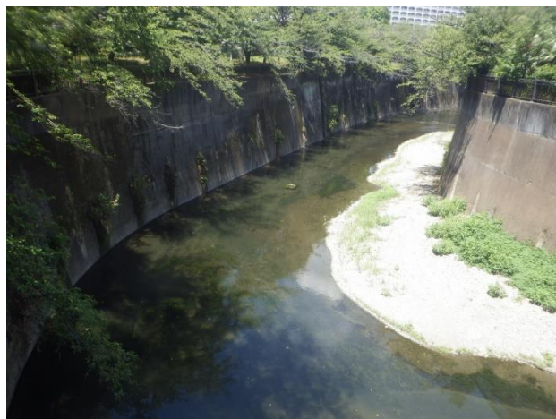
石神井川 ②緑橋付近 緑橋下より上流方向
