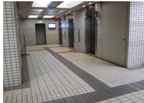
【北館1階の法定ブロック】 グレー色とし、白色の床とコントラストをつけている。
