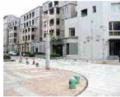
段差を解消しボラード（車止め）を設置した歩道整備例
