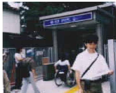
新たに整備された川越街道沿いのエレベーター出入口
