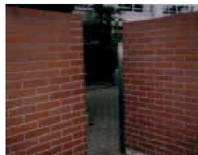
車椅子利用者が通行できる幅員 確保が必要な通用口（小学校）
