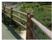
遠目では、ほどんど気づかない細い材で 低コストで仕上げつつも、透過性を確保し 間伐材を用い周囲のみどりに馴染む落ち ついた柵
