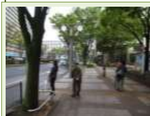
十分な歩道幅員があるものの、一部のバス乗降場でバス停上屋が設置されていない。
