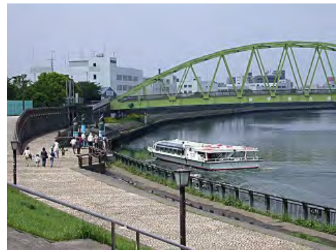
新河岸大橋付近
