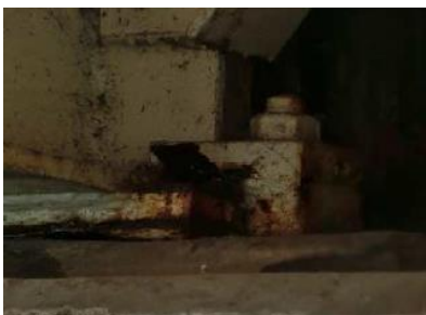
双栄橋の工事前
