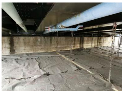
西堰橋の工事前
