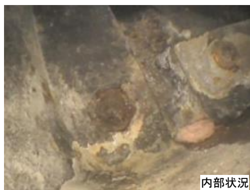
芝原橋（ファイバースコープカメラによる点検）
