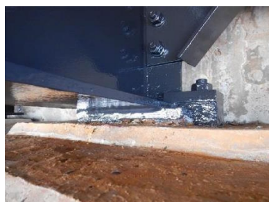
双栄橋の工事後
