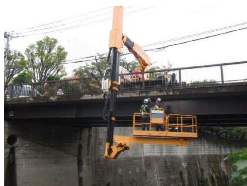
加賀橋（橋りょう点検車による点検）
