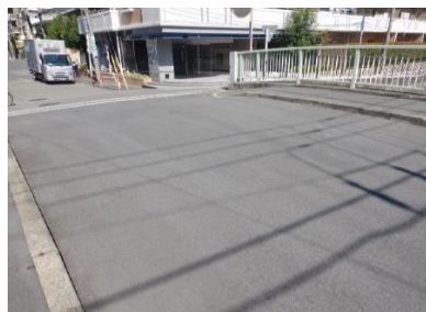
成和橋の工事後
