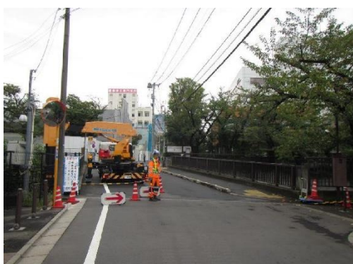
加賀橋（橋りょう点検車による点検）
