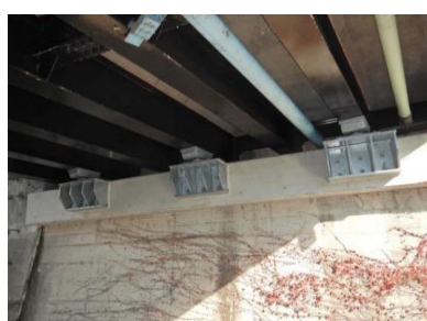
西堰橋の工事後
