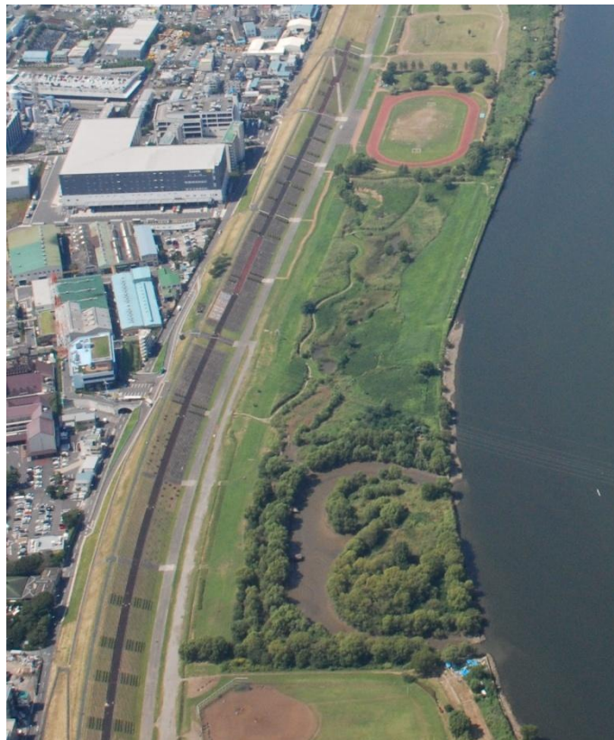
板橋生物生態園付近の護岸（26.0km 付近）
