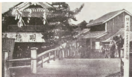
明治8年頃の板橋
