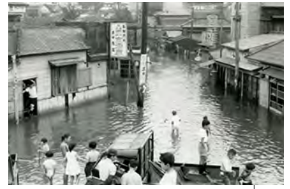
昭和33年／台風22号による被害(現本町)
