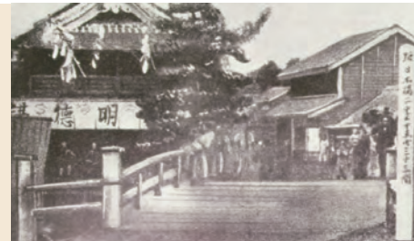
明治8年頃の板橋
