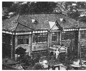
昭和7年/当時の区役所庁舎
