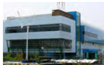
リサイクルプラザ C-1 ゴミ処理ゾーンとリサイクルを学べるプラザゾーンがあります
