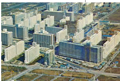
昭和44年／高島平団地の建設
