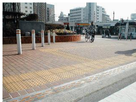
板橋駅前に設置した様子
