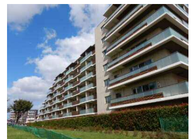
拡張区域に隣接するマンションの外観
