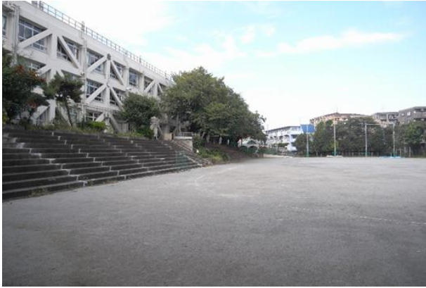
①屋外運動場と校舎は3m強の段差がある。
