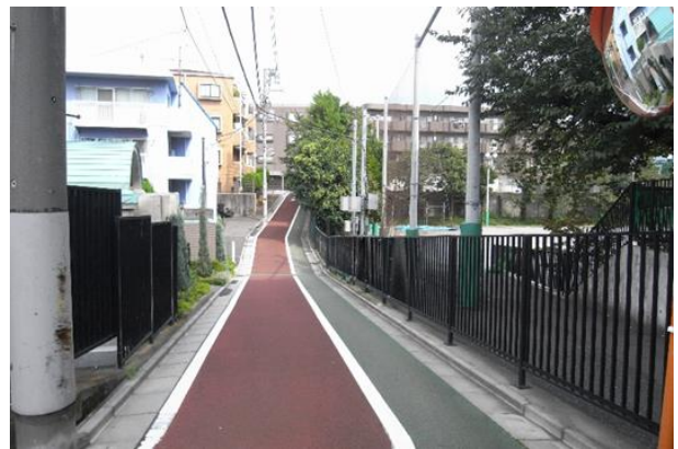
⑥北側道路は屋外運動場まで下がっている。
