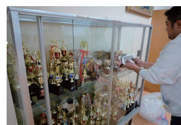
ガラス飛散防止フィルム貼り
