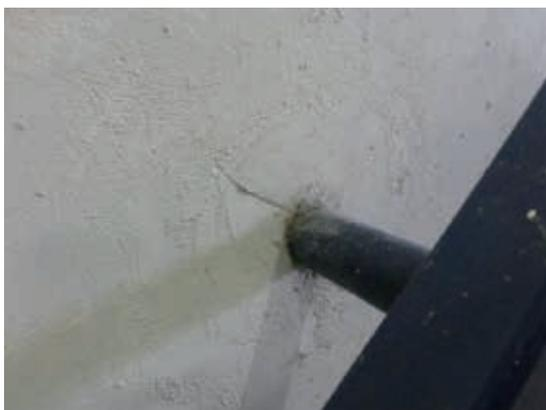
[写真 11] 階段手摺の壁面への取付け
