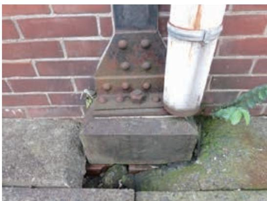
〔写真 31〕正面の H 型鋼の柱
