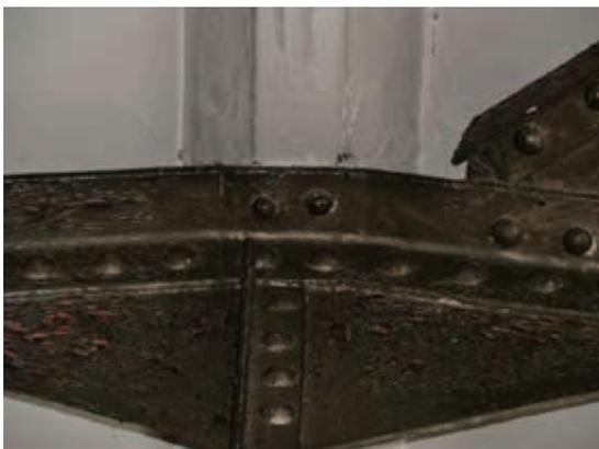
〔写真30〕 小屋組と母屋桁の接続部
