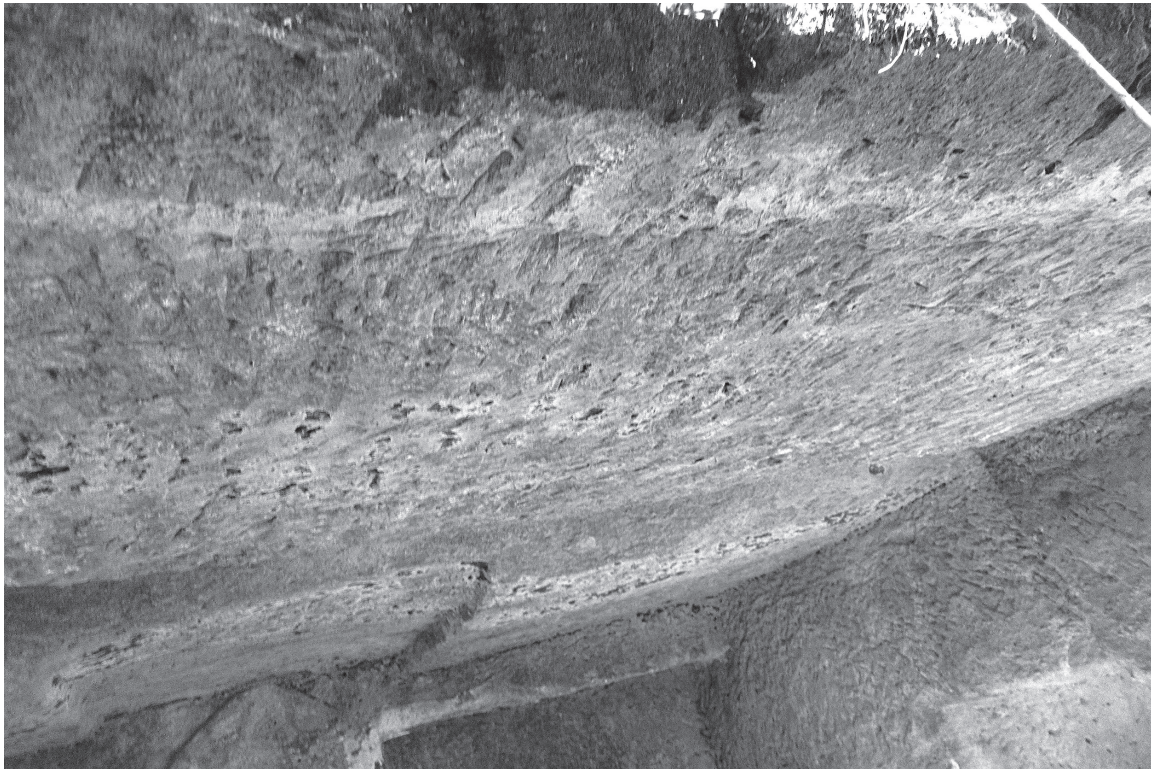
朱だるきやぐらの玄室天井に残る朱色塗装
