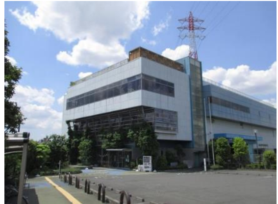
板橋区立リサイクルプラザ
