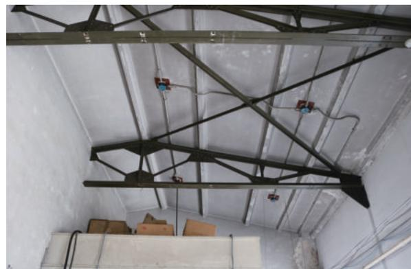
鉄骨リベット接合の小屋組み（D棟）
