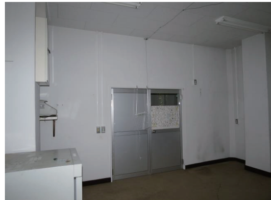
〔図 10〕 119 号室から隣室を望む
