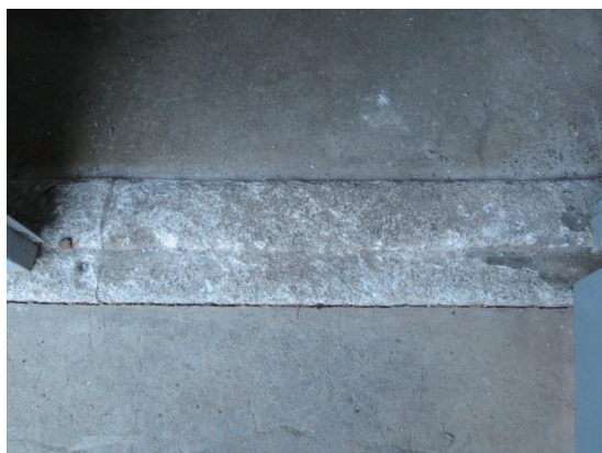
[図3] 1階西側出口の沓摺
