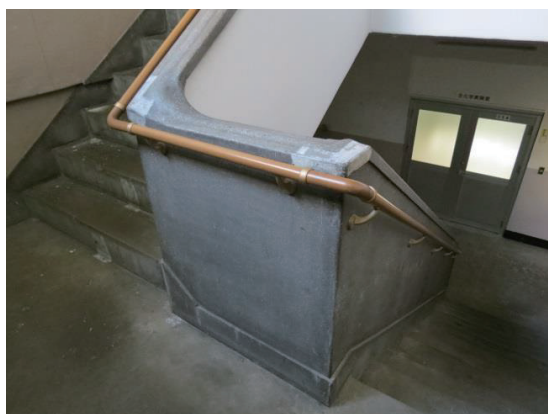
[図5] 階段踊り場の手摺壁
