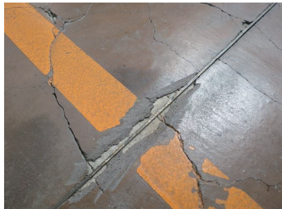
[図 25] 床の真鍮製の目地棒
