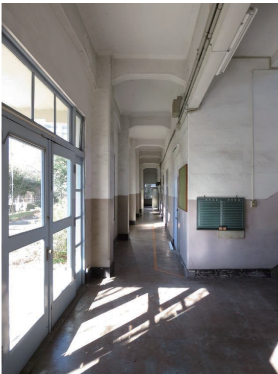
〔図 32〕 中央玄関を入れて西を望む
