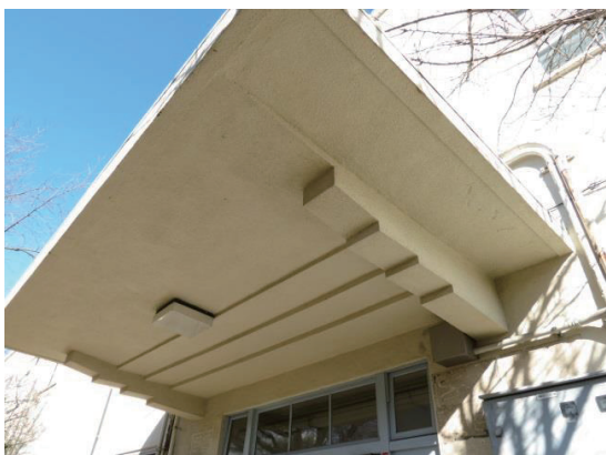
〔図 36〕 段差が設けられた持ち送り
