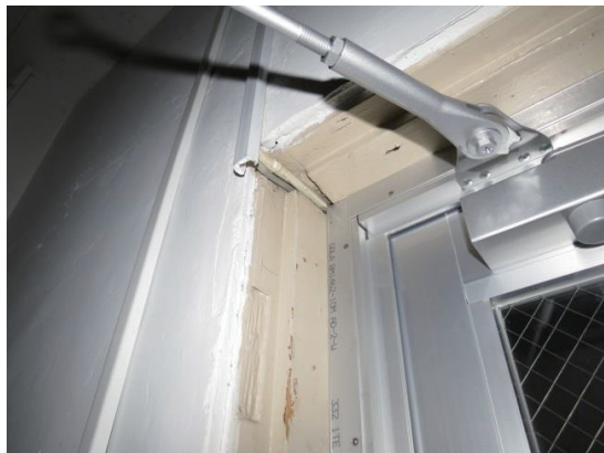
[図 11] 木製の建具枠跡
