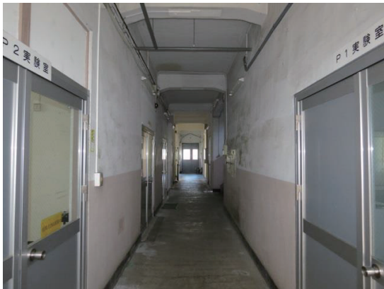
〔図 9〕 左側 P 2 実験室 欄間は埋められている。右の 119 号室は欄間がない。
