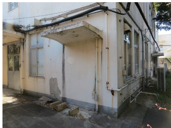
[図 17] 119 号室部分の庇
