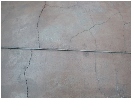
[図 24] 床の真鍮製の目地棒
