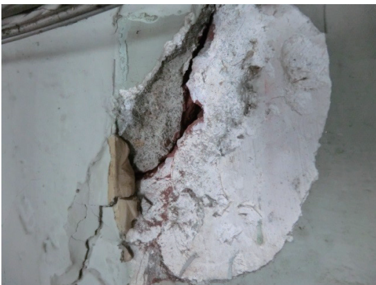
[写真 33] 玄関4号室側の壁
