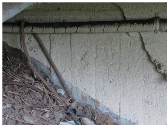
【写真 2】 テラス下の壁面にある縦板の型枠跡
