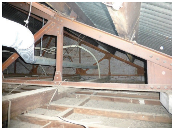
〔写真 37〕 家政大学 58 号棟
