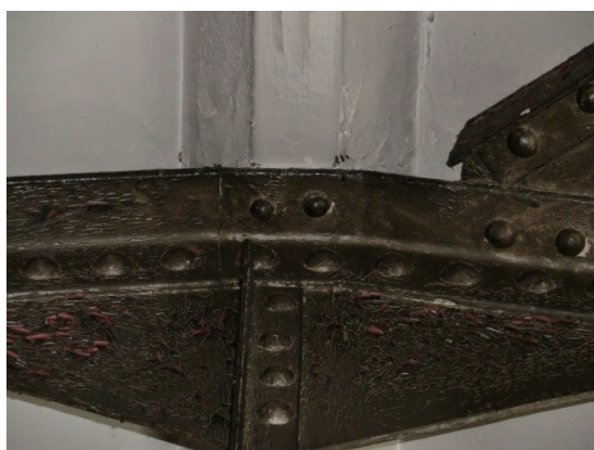
〔写真30〕 小屋組と母屋桁の接続部
