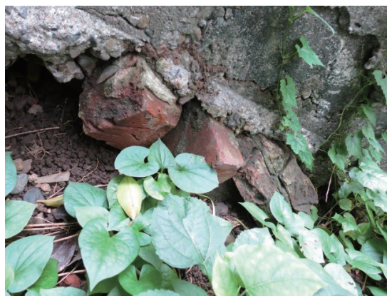
[写真 15] 階段基礎の赤レンガ片
