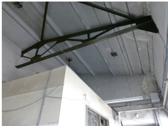
〔写真 35〕 D棟小屋組
