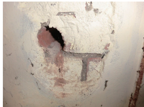
[写真 34] 軌道の部屋と会議室との境（腰部分）
