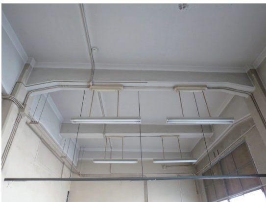
〔写真18〕 9号室天井
