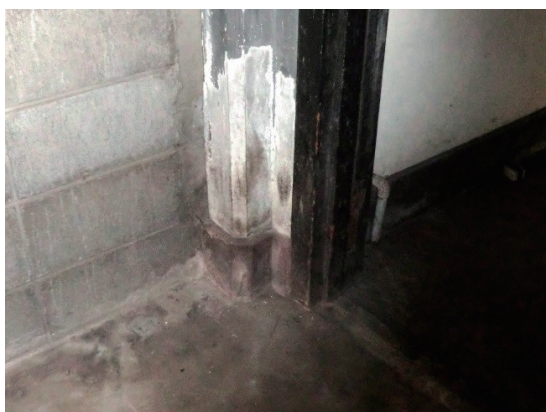
[写真 22] 廊下と 10 号室の壁面出隅部
