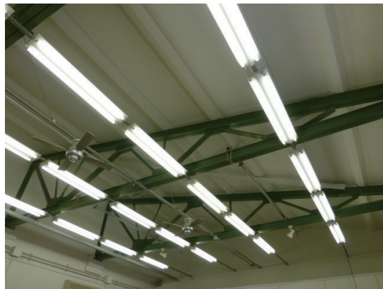
〔写真 36〕 家政大学 22 号棟
