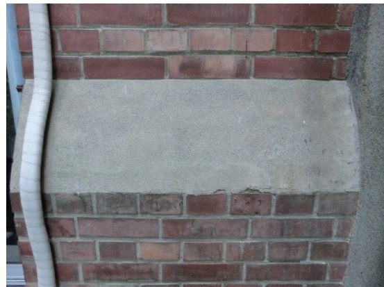
[写真 27] 背面外壁腰壁
