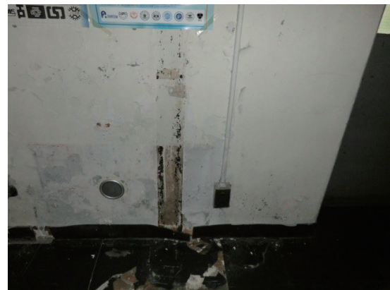
[写真 32] 会議室内のH型鋼の柱
