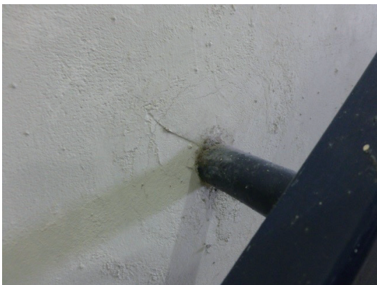
[写真11] 階段手摺の壁面への取付け
