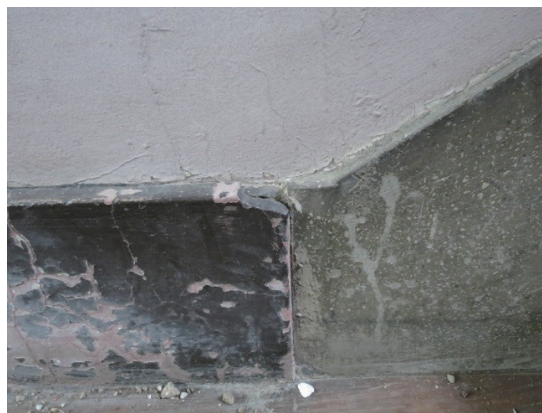
〔写真 40〕 火薬研究所 階段取り合い巾木
