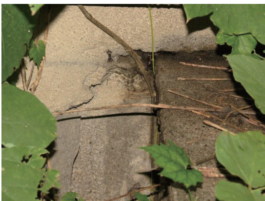
【写真 1】 テラスと外壁との取り合い
