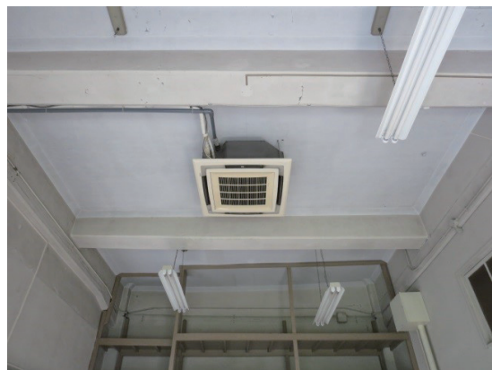
〔写真19〕 10号室天井
