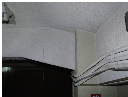
〔写真7〕 地下北側 ハンチの一部は壁面内 〔写真8〕 地下南側梁のハンチ 天井も傾斜
