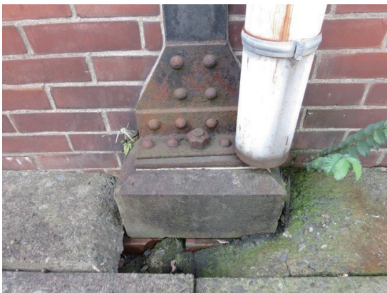
[写真 31] 正面のH型鋼の柱
