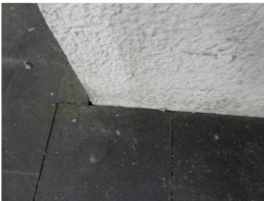
[写真9] 柱と床の取り合い
