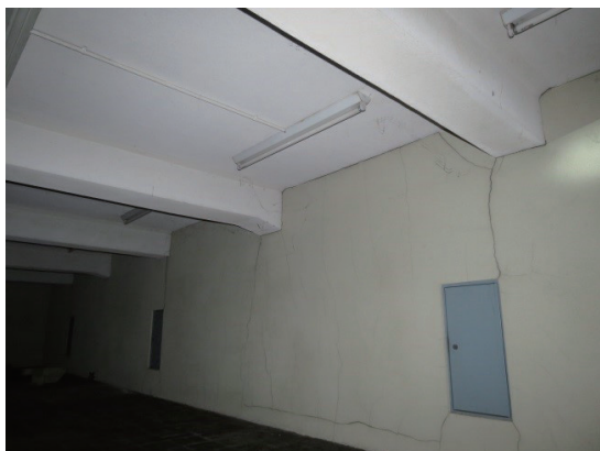
〔写真7〕 地下北側 ハンチの一部は壁面内 〔写真8〕 地下南側梁のハンチ 天井も傾斜
