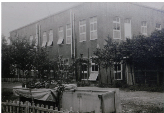
写真4. 野口研南面（昭和37年8月～昭和48年5月）板橋区提供
