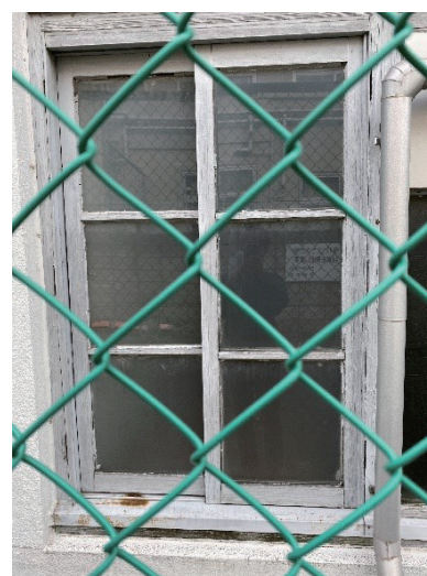
写真 1. C 棟の木製引き違い窓
