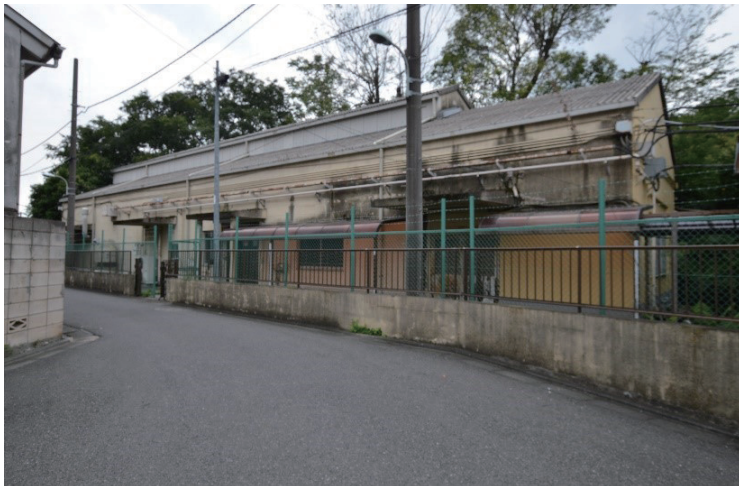
写真2. 板橋区火薬製造所B棟北面
