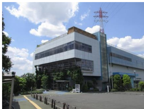
板橋区立リサイクルプラザ
