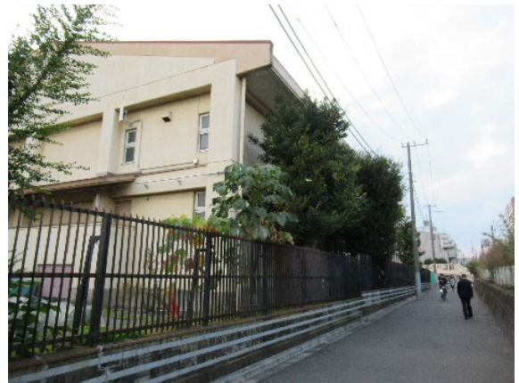
⑥東武東上線 - 校舎間の道路
