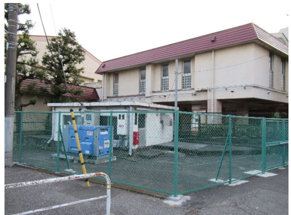
④南常盤台排水場 ※敷地に近接するため、調査及び協議を要する
