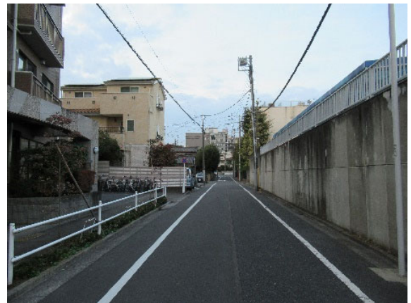
⑩敷地南西側 道路
