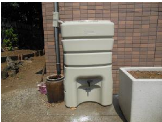
雨水タンク（治水対策）
