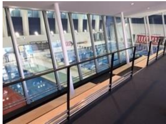
小豆沢体育館プール棟の地中熱利用 (プール棟共用部を中心に、地中熱を活用した空調システムを採用)
