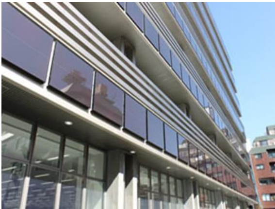
区役所本庁舎南館壁面の太陽光パネル (自然エネルギーを有効活用するため、発電能力 75kW に及ぶ太陽光パネルを南館屋上のほか南側壁面にも設置)
