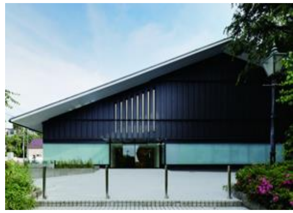
板橋区立美術館の大規模改修(長寿命化) (LED照明を使用し、外断熱を施すことで、環境にも配慮した施設としてリニューアルオープン)
