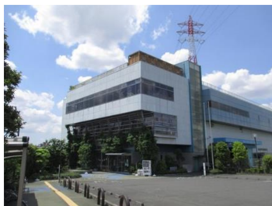
板橋区立リサイクルプラザ
