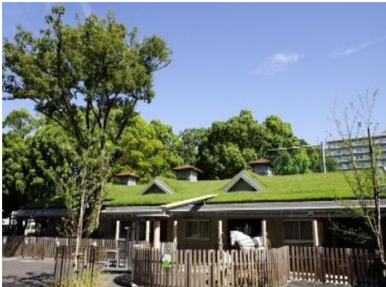
板橋こども動物園園舎の断熱化 (室温を一定に保ち、冷暖房機器の使用を抑制するため、改修工事に伴い、草屋根や壁面緑化を実施)
