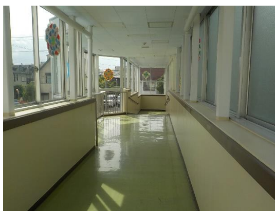
設備改修後の廊下
