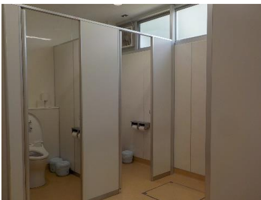
設備改修後のトイレ
