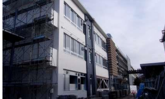
改修中の舟渡小学校校舎
