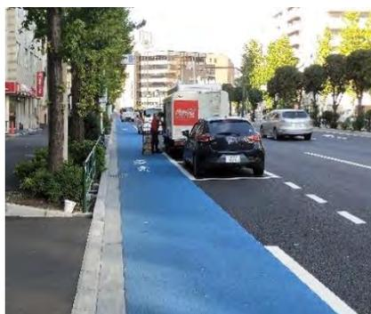
写真：自転車通行帯の右側に駐車スペースが設置された例（文京区内）
