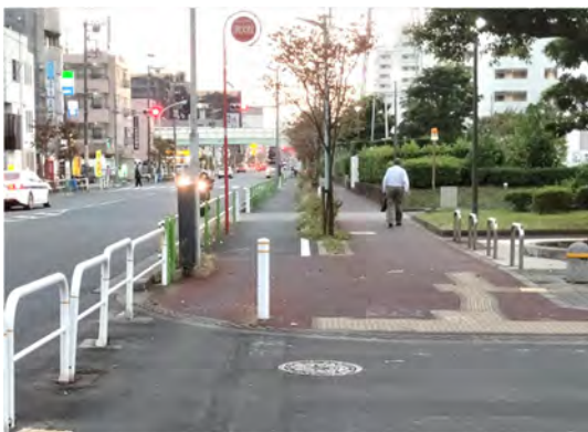
写真：歩行者と自転車の通行帯を構造分離した歩道（高島平二丁目）
