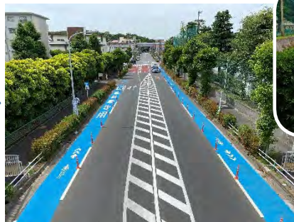
写真右：施工後（令和3（2021）年5月撮影）
