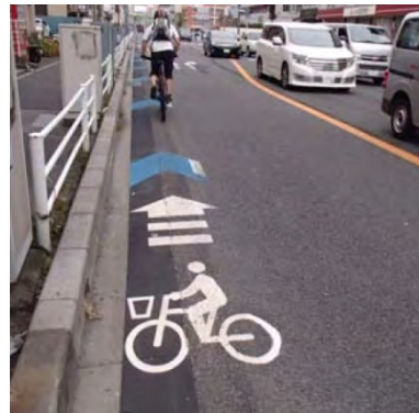
矢羽根型表示（車道混在）の路面表示
