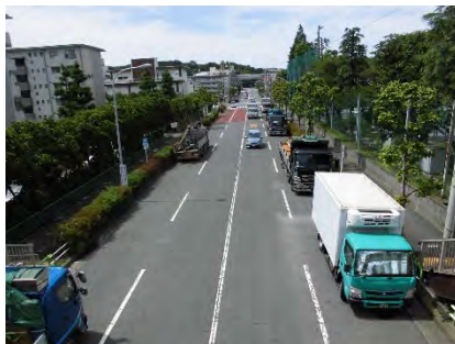
写真左：施工前（令和2（2020）年6月撮影）
