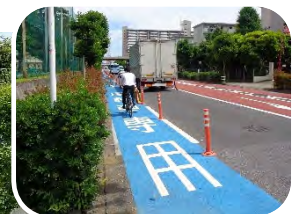
樹脂製ポールの設置区間(拡大写真)
