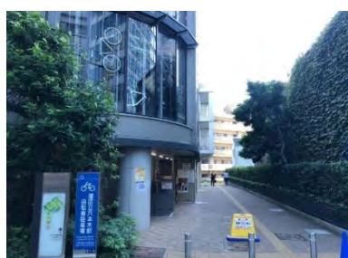
写真：駅近くの建物内に駐輪施設を組み込んだ自転車駐車場（港区六本木）
