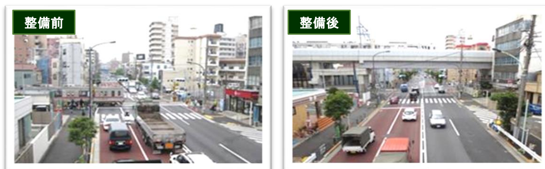
「立体交差化の整備前後事例」（京成押上線[押上駅～八広駅間]明治通り）
