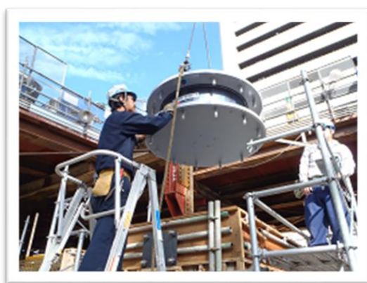
「免振装置の工事の様子」
