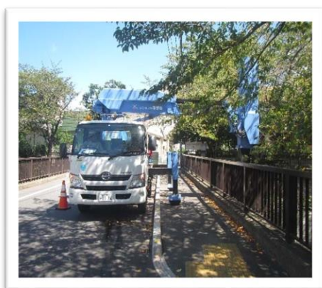
「加賀橋（橋りょう点検者による点検）」【出典：板橋区橋りょう長寿命化修繕計画（第2期）】
