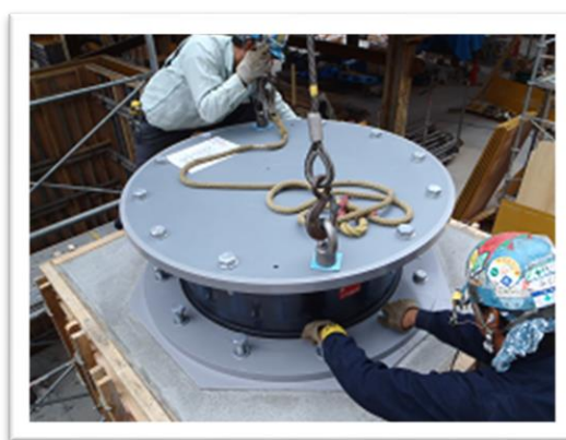
「免振装置の工事の様子」
