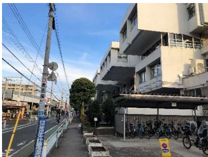
⑦ 北側歩道を見る
