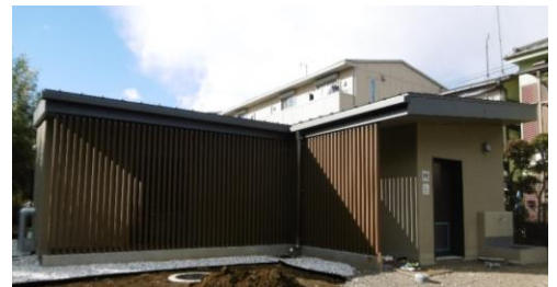
新設した管理棟
