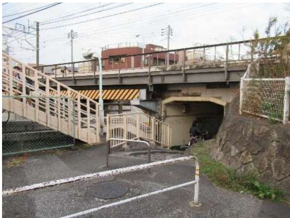
⑤敷地北側 東上線高架と環七を渡る歩道橋
