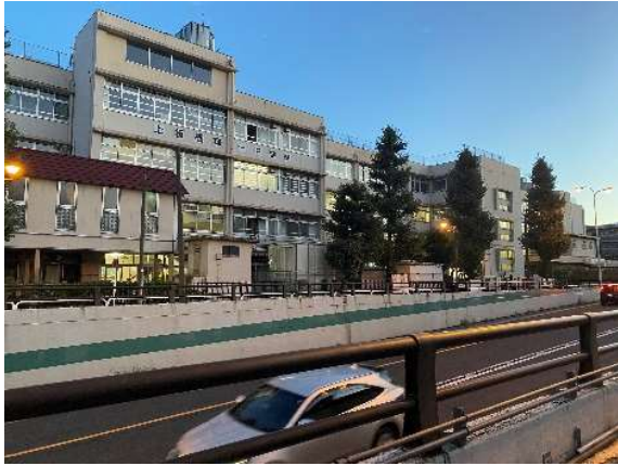
①環状七号線から正門を見る
