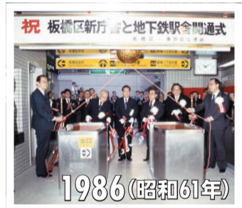
区役所の新庁舎と地下鉄駅舎の開通式です。駅直結の庁舎となり、利便性が向上しました。
