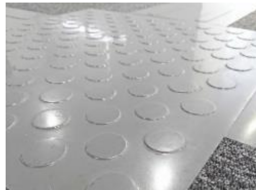
南館のブロック。突起の高さは1.0mm程度。点の突起を交互に配置することで、認識しやすいものになっている。
