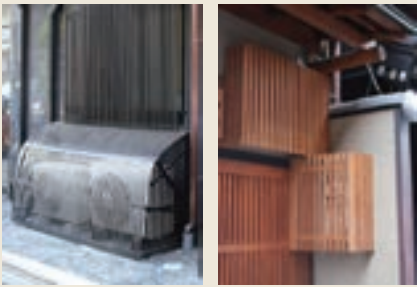
空調室外機やメーター等を修景した例(他都市)
