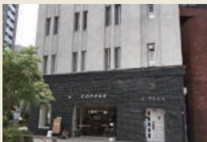
レトロ建築をカフェとして活用した例(他都市)
